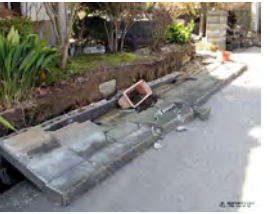
危険コンクリートブロック塀等の除却
