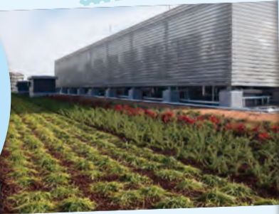
屋上の緑化。室温の上昇を抑え、空調機器の負荷を低減している。
