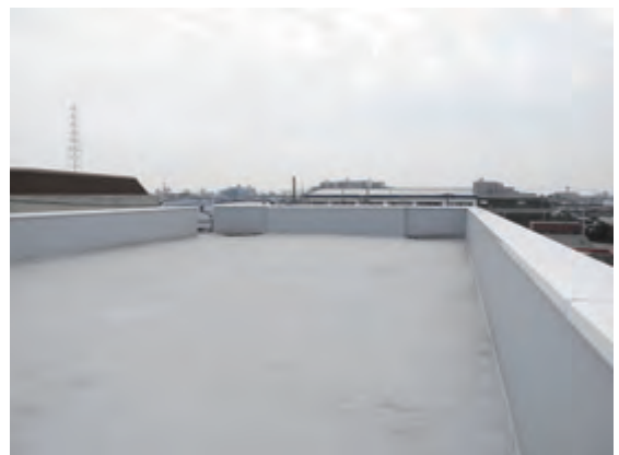
屋上から左図の内側を見る
