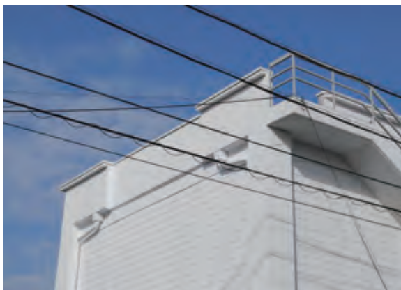
南面には、起重機からの上げ下ろしのために開放されていた パラペットを埋めた跡がある
