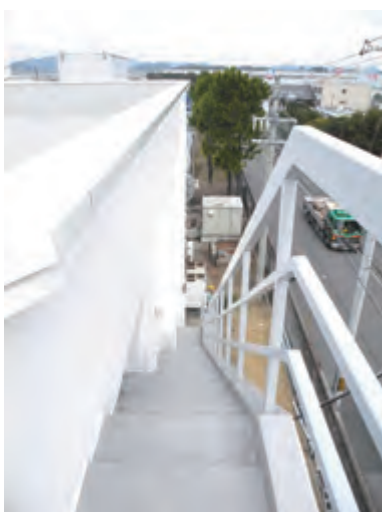
外階段 1985年写真に写る手摺りと異なる
