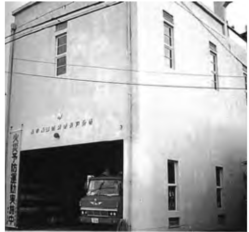
アルミサッシに更新される前の消防署の窓廻り。 上げ下げ窓は木製か。各窓には横棧が1本入る。
