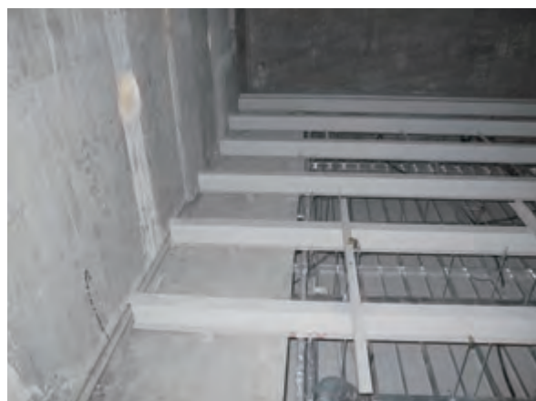
回廊 内周には手摺りを撤去した跡がある。レールのような「映写幕」移動装置の痕跡はない。
