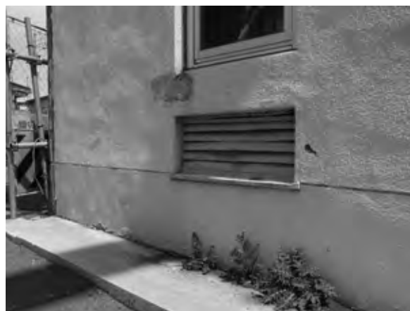
1階窓下には、当初材のガラリ付き換気口が残る
