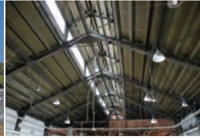
砲廠 小屋組も鉄骨からなる
