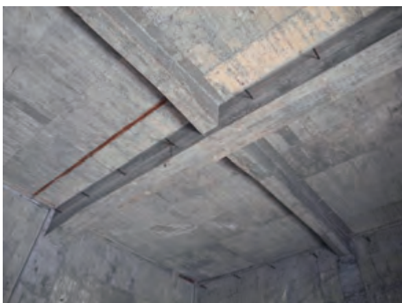
壁と天井には、型枠を締めつけた鉄棒が規則正しく並ぶ。型枠には当時一般的であった幅の狭い板材が使われている。
