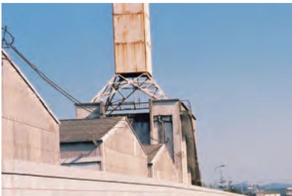
右図詳細。南面中央にはパラペットがなく、起重機を構成した袖壁が残る。(袖壁は次ページ掲載1974年写真にも写る)
