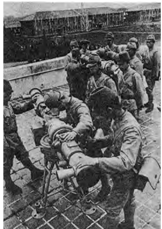
照空予習室屋上での訓練。「敵機の正体を見つけたらただちに測高機で高度と航測を測定する」 床がタイル張りであったことがわかる。茶褐色のクリンカータイルと思われる。 『軍服の青春(陸軍編)』より
