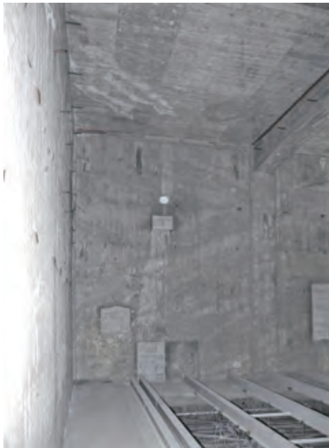
室内 2 階西壁には、右図に見る突出部に続く開口部を埋めた跡が残る。画面左端は、投影機用開口部か。
