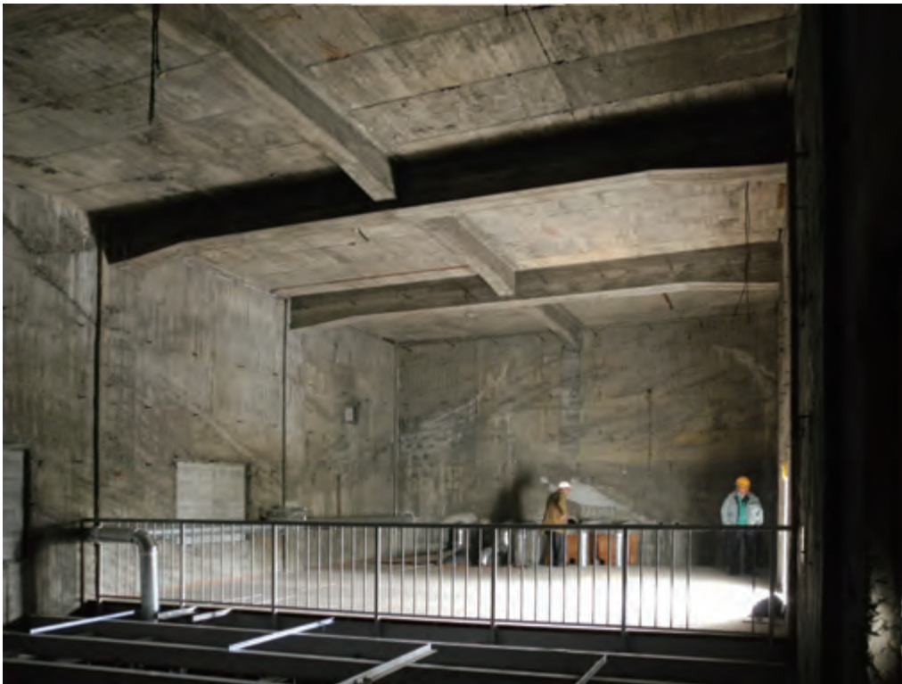
室内 北西を見る。2階は建設当初の姿で残る。壁は柱真より内側に設けられており、柱が壁面から突出しない。
