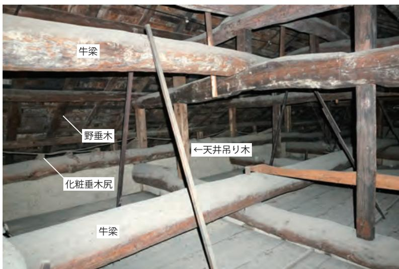
小屋組下方、正面側を見る。化粧垂木の尻が見え、軒裏に懐があることがわかる。牛梁に掛けた斜材を天井吊り木として野縁を支える。
