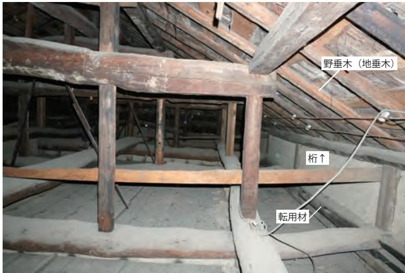
画面右が背面側。柱材の転用（桁の下の部材）他、燻けた古材（前身建物の転用材か）が見られる。野垂木（地垂木）は桁を越えて軒廻りを構成する。
