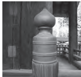
縁高欄親柱の擬宝珠
