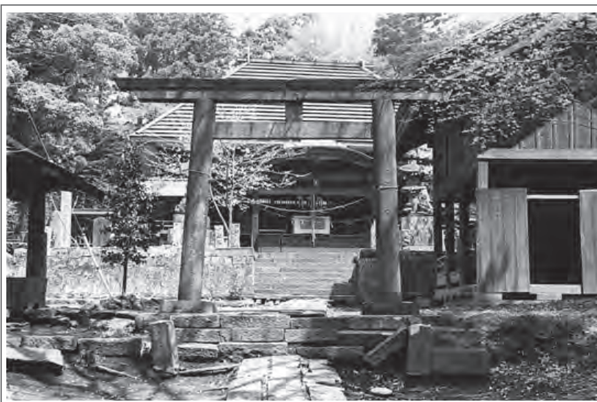
鳥居から拝殿を見る。現社務所（画面右）の柱間は開放されており、神楽見学者をもてなすのに利用されていた。 撮影時期不明 [市教委蔵]
