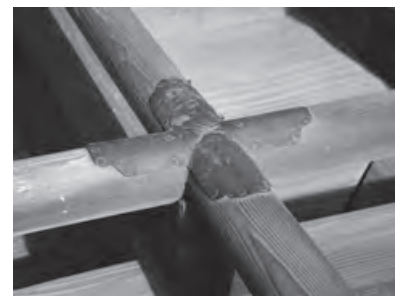
縁高欄架木(ほこぎ)交差部の 銚金物
