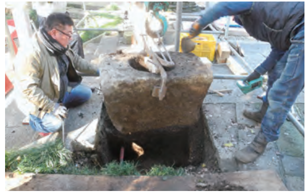
2 根石を吊り上げる。
