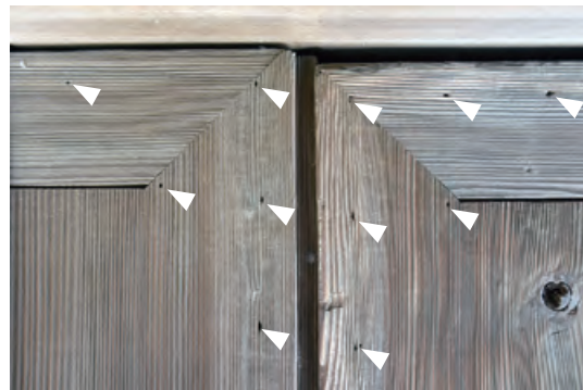
写真5 銹金物 C の釘穴<春日社>
