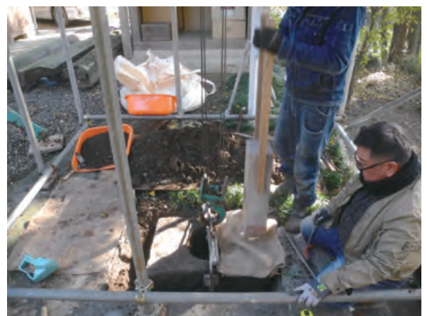
6 根石の据え直しは、柱の傾きが左に揃うように外側に40ミリ移動し、木の根により持ち上げられていた分低くした。地面をすきとり、タコでそっと叩きながら調整。
