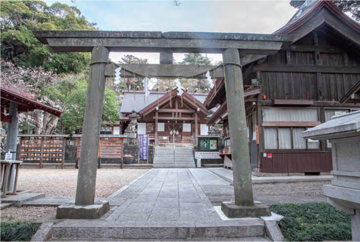
修理後の鳥居 正面
