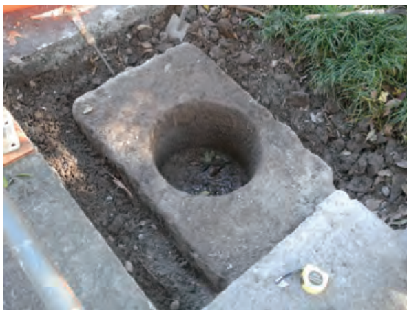
3 【工事対象】正面向かって右側の柱の沓石と周囲のコンクリートを撤去した状態。根石が現れた。左右の柱を繋ぐ地中梁のような構造はない。(画面左下が鳥居の中心の向き)
