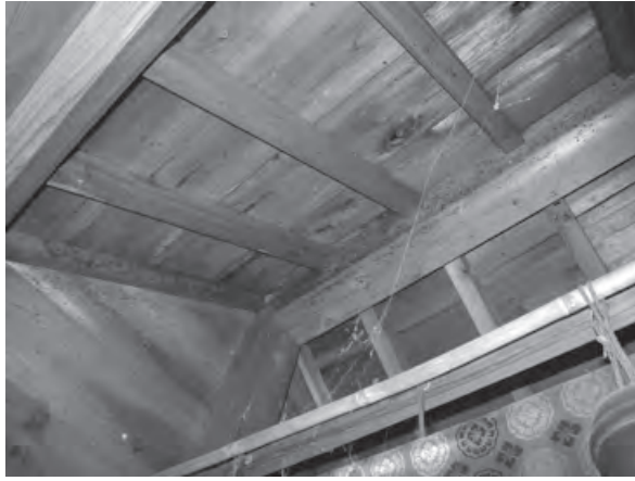
屋根裏見上げ
