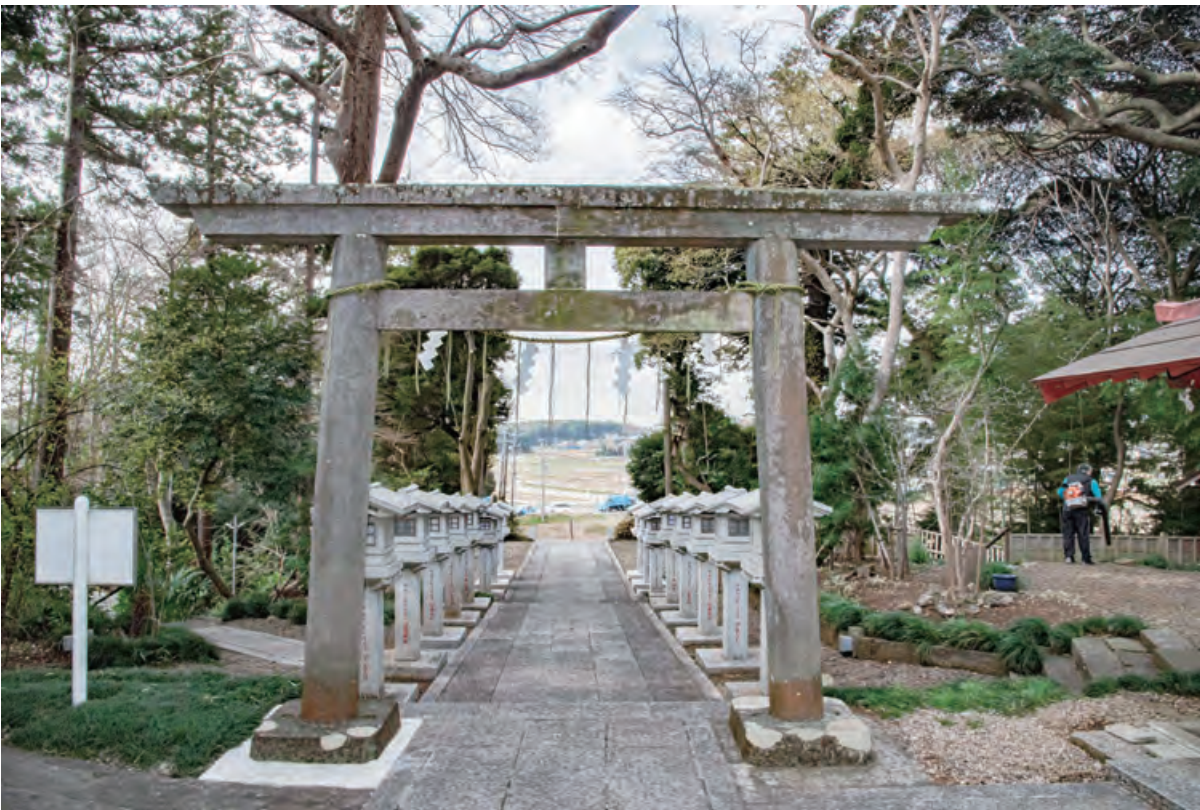
修理後の鳥居 背面
