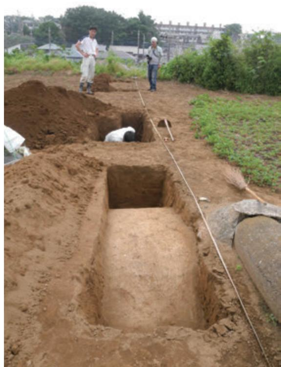
図 3-28 地層を見るために文化課が発掘を行った掘り出されてあらわになった燃料庫上面外側からコンクリートが塗られている
