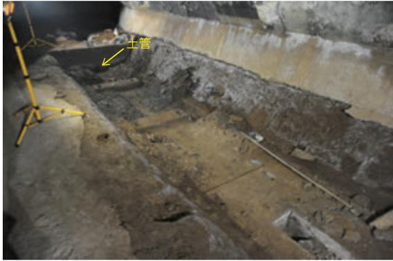
基礎 C 末広がり基礎が2個、北端（画面下方）の基礎は北側が床2の叩きと同じ高さ。中央に溝がない
