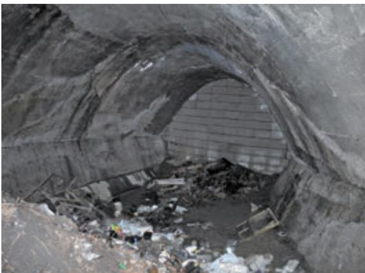
図 3-37 燃料庫最奥の西開口部は、セメントブロックで塞がれている
