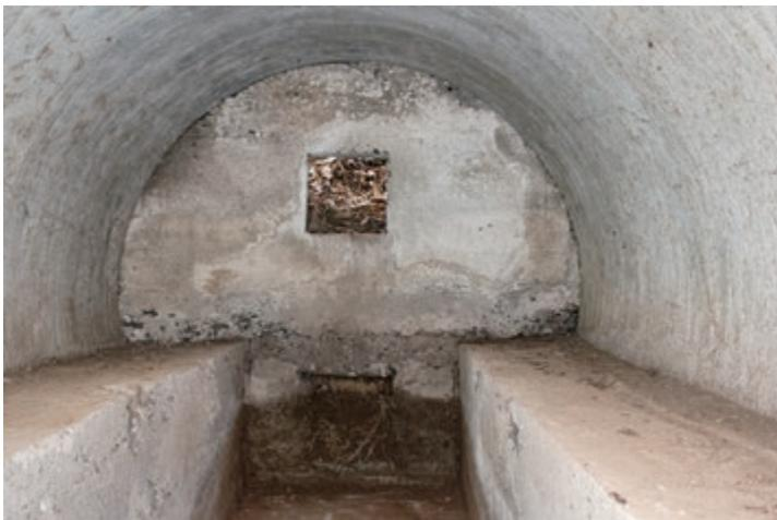
図 2-53 柏市の柏の葉秋水燃料庫と比べて、施工誤差による多少の寸法の違いはあるが、端部の壁や棚の構造は、同じである。型枠に用いられた板は1尺幅
