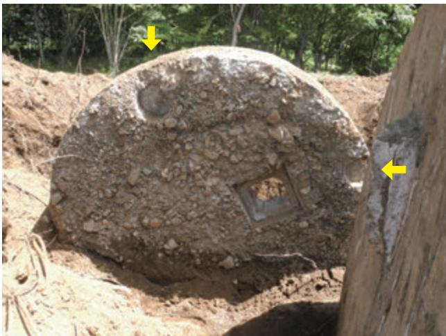
図 2-29 水槽底の裏側には、円形の杭の跡が残る
