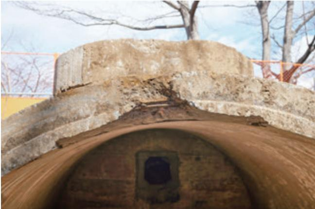
図 2-19 ヒューム管には鉄筋が入っていることが破損部からわかる。鎌ヶ谷の事例では、ヒューム管同士はモルタルで接続されている
