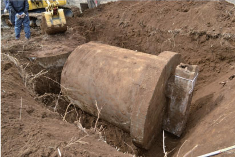
図 2-23 当初は画面右の連結管の上にあった水槽の底板が、画面左に見える。ゴルフ場造成時に移動されたものと思われる
