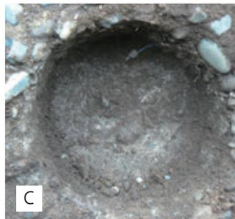
底板の裏面には、直径約 20 cm の丸太の上端の跡がある。底板は、円形の型枠を周囲に回し、地面に直接コンクリートを流して造られた
