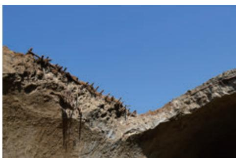
図 2-38 ヒューム管の破損部より、鉄筋が縦横に配されているのが見えた
