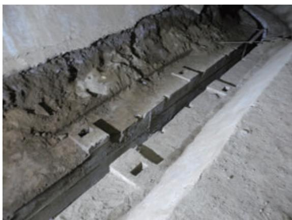
図 3-10 基礎には燃料タンクを設置するためのホヅ穴がある
