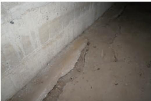
図 3-61 コンクリートを直接地面に流して造られた床
