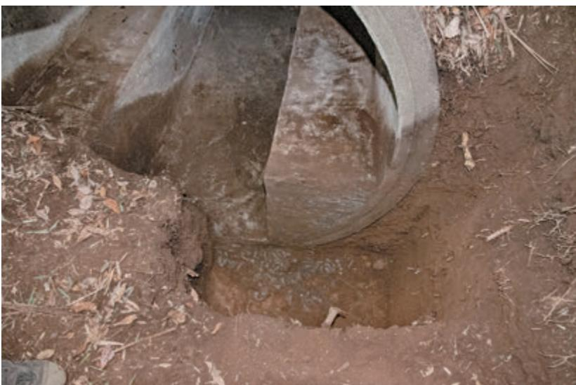
図 2-51 出入口のある端部では、地中に基礎が確認された。コンクリートか石かは不明
