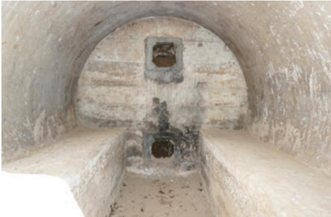
図 2-13 内部には、コンクリートの棚を造る。棚はヒューム管に緊結されていない。端部の壁の穴の外側には、コンクリート製の連結管が取り付け
