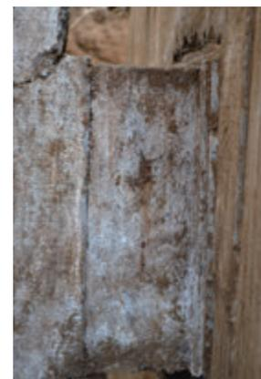
図 2-27 連結管には、帯ノコ挽きされた板材からなる型枠の痕跡が残る
