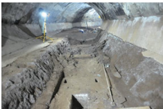
図 3-12 土砂をさらい見えるようになった床面の基礎や溝
