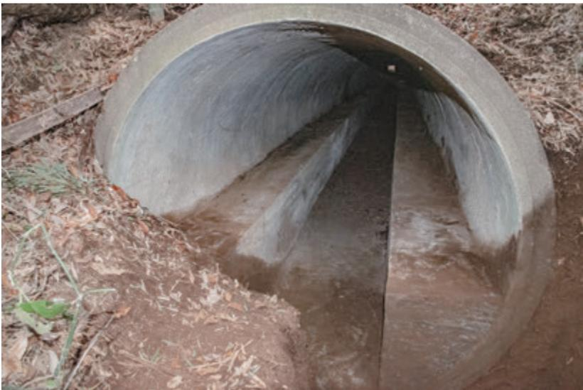
図 2-50 ヒューム管の端部が出入口となる。この前方には、鍵の手に折れる簡易な構造物が計画されていた
