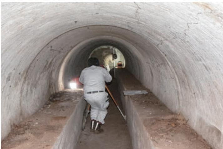
図 2-54 内寸 1800 mm のヒューム管にモルタル塗で平らな床を造る。床面からの高さは最大約 1700 mm しかない
