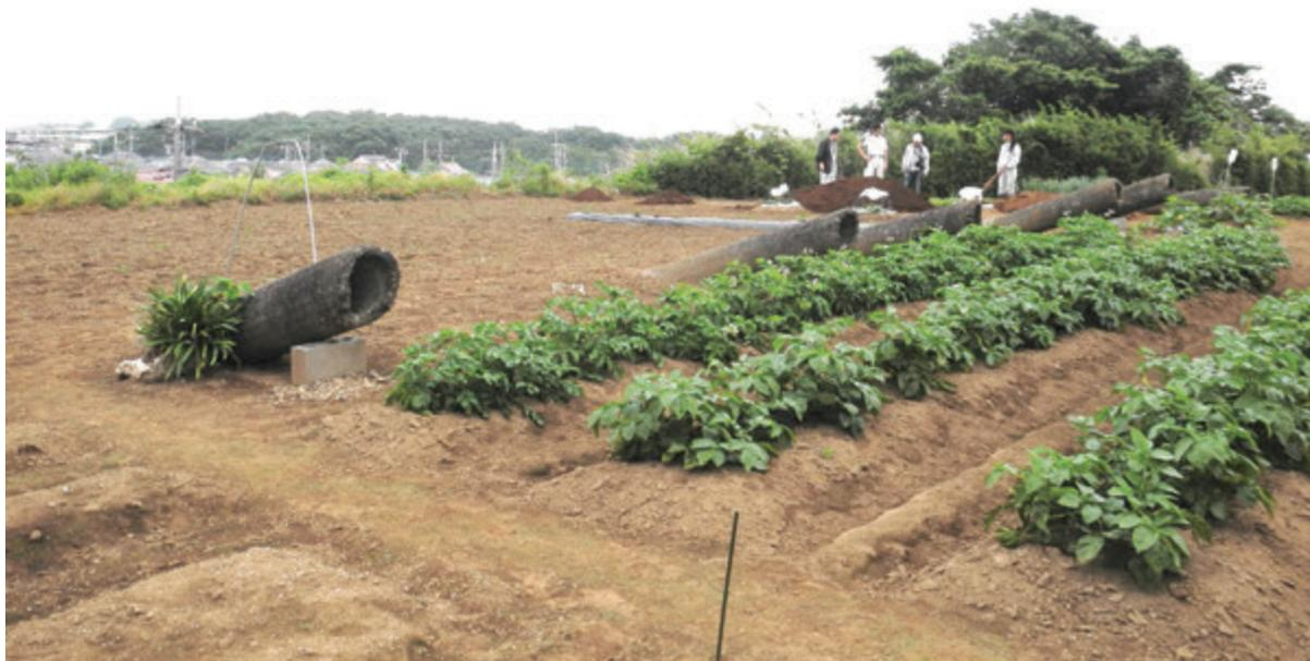
図 3-4 地上に現れる燃料庫の 6 本の換気筒
