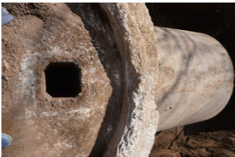
図 2-12 水槽底の穴は、コンクリート製の連結管を通して、ヒューム管へと繋がる（柏の葉 4 号、1 号燃料庫参照）
