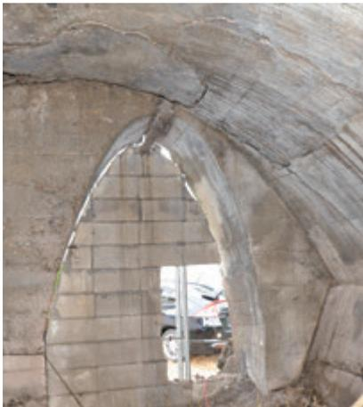
図 3-30 東端の開口部は、セメントブロックで封じられている。ここに北出入口への通路が取り付く計画であったが未完である
