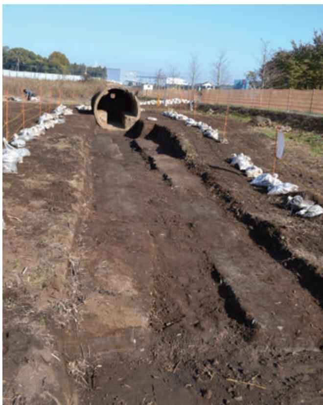
図 2-41 ヒューム管の下方両脇を支えるように、コンクリート塊が2列並べられている
