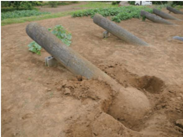
図 3-26 換気筒の根本は饅頭型のコンクリートで取り付け
