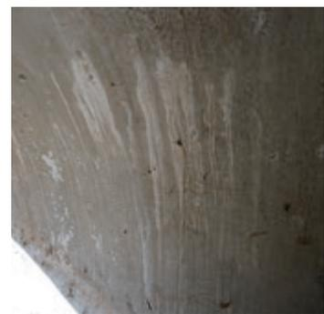
図 2-18 ヒューム管内側には、撥水剤のような塗膜がある
