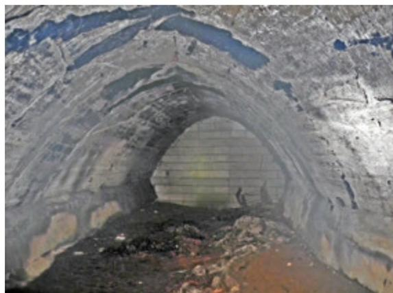
図 3-8 南出入口はセメントブロックで封鎖されている
