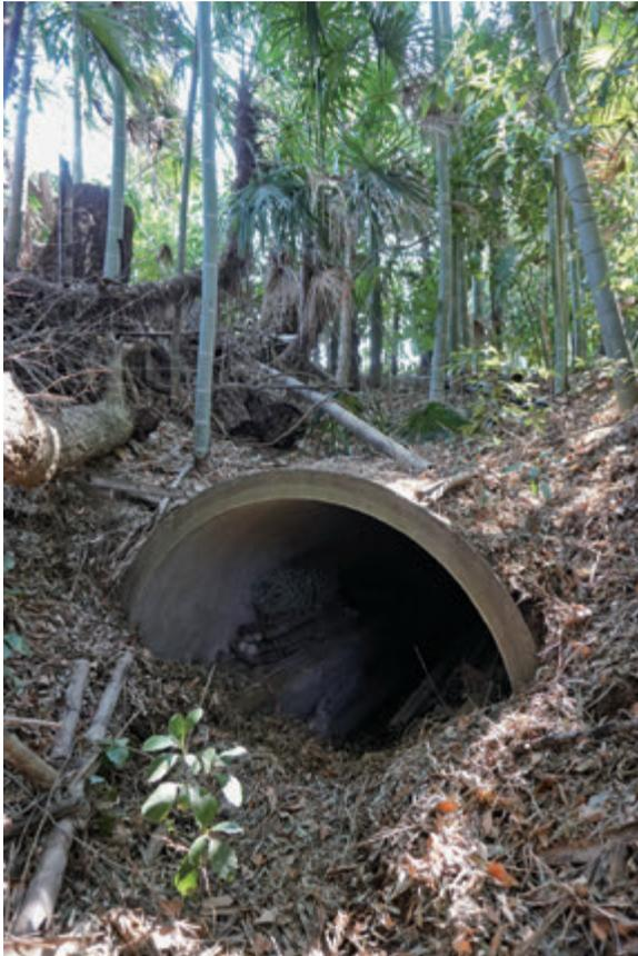
図 2-46 ヒューム管端部が、出入口となる
