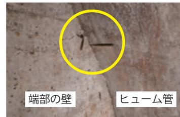
図 2-15 ヒューム管端部の壁打設時に型枠を止めた釘が残る (○内)
