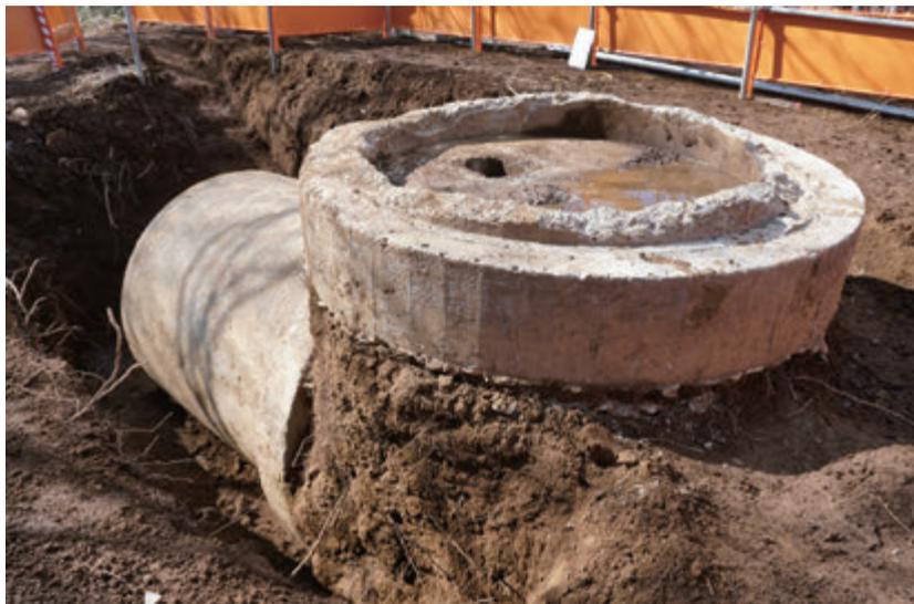
図 2-10 水槽の底板が残る
