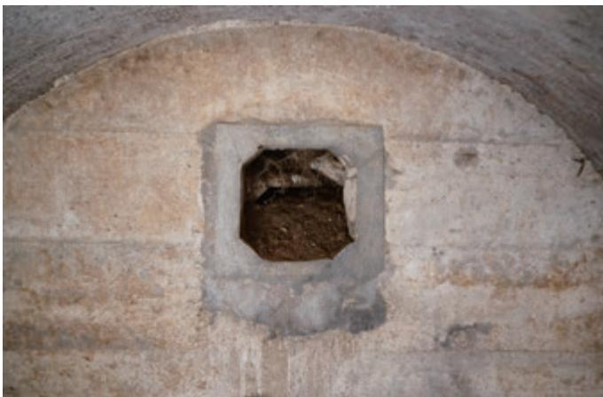
図 2-17 連結管取り付け部詳細
