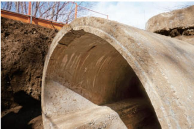
図 2-20 ヒューム管の継ぎ手部分には極浅い溝がある
