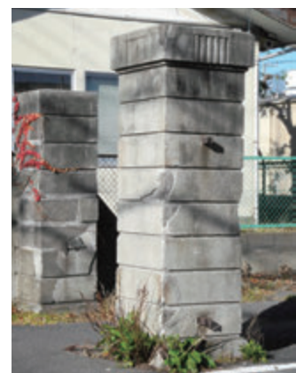
図４－８ 門柱詳細 門扉の取り付け肘壺金物が残る
