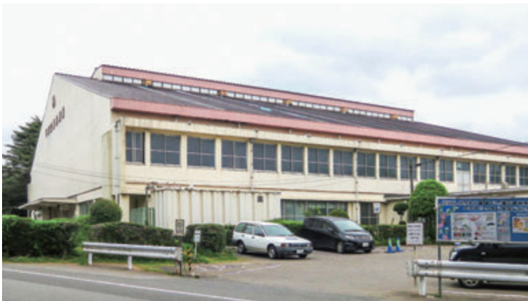
図4-2 千葉公園体育館正側面 2023年4月撮影
