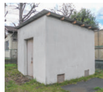
図４－６ 左図の小さな建物（詰所か）鉄筋コンクリート造、片流れ屋根（現存せず）
