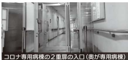
コロナ専用病棟の2重扉の入口(奥が専用病棟)
