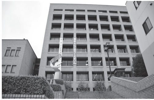
耐震工事を予定している市役所本庁舎
