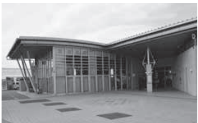
機能強化を進めている道の駅しょうなん
