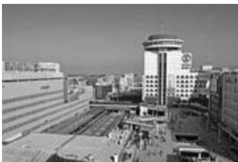
改築後の柏駅東口ダブルデッキ
