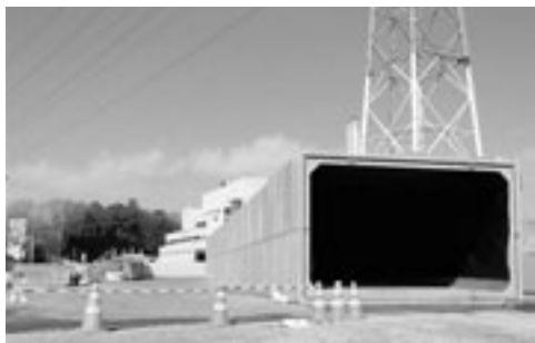
北部クリーンセンターに設置されたボックスカルバート
