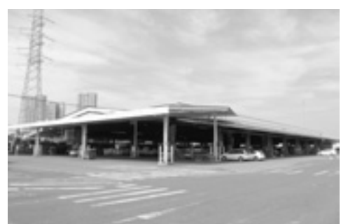
耐震改修を予定している公設市場青果棟
