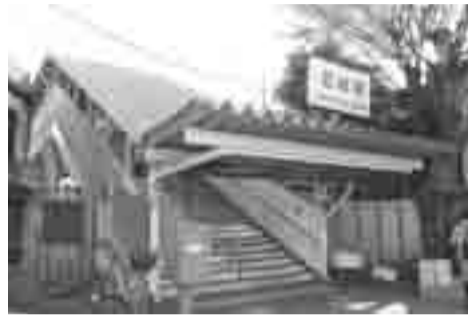
北柏駅北口の連絡通路
