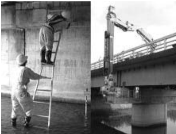
橋梁長寿命化計画に基づく点検調査
