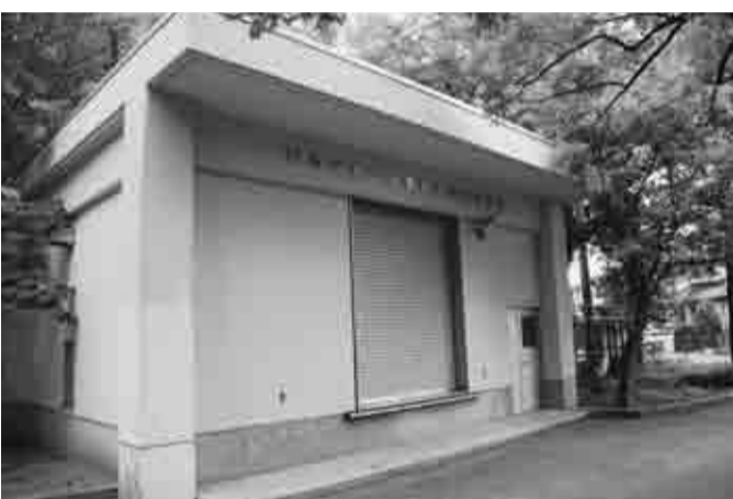
柏第三小学校の防災備蓄倉庫
