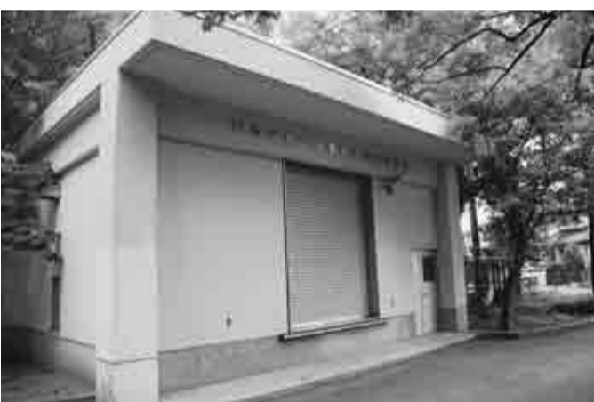
柏第三小学校の防災備蓄倉庫
