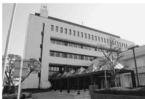
支所機能を持った沼南庁舎
