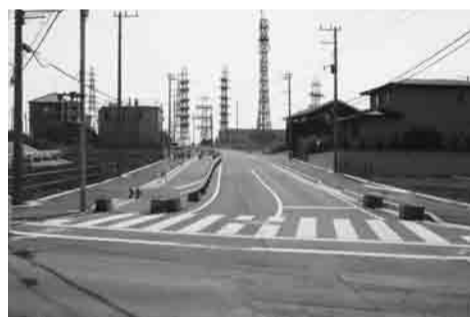
整備中の高柳駅西口進入路
