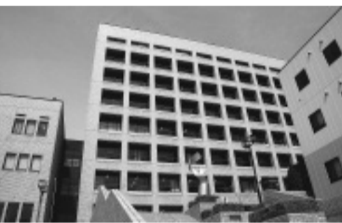
PPS(新電力会社)を導入する市役所本庁舎
