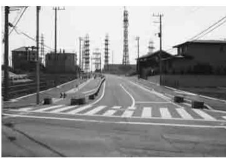
整備中の高柳駅西口進入路
