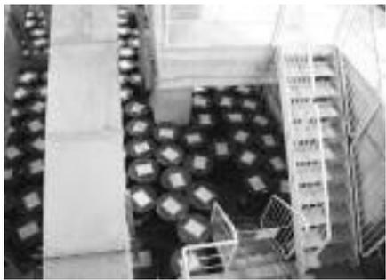
灰溶融飛灰固化物のドラム缶保管
