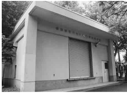
防災備蓄倉庫(柏第三小学校)
