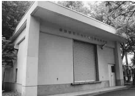
防災備蓄倉庫(柏第三小学校)
