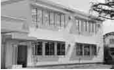
風早北部小学校仮設校舎
