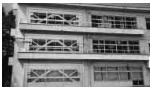
柏第三小学校（校舍耐震改修）
