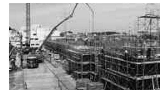
建設中の総合保健医療福祉施設
