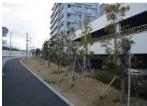
植栽による立体駐車場の修景
