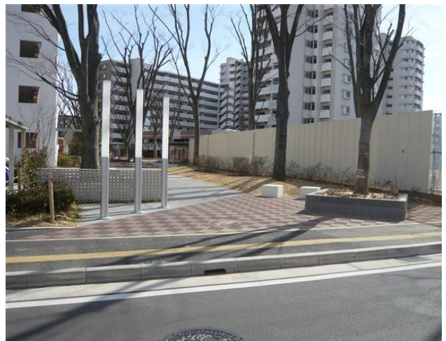
・四季のみちノード部のボール照明
