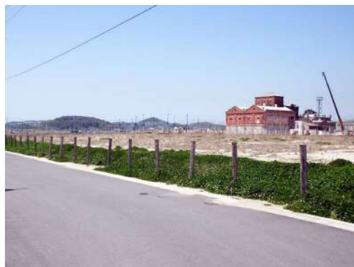
敷地のきわを播種で緑化し、修景するとともに土砂の飛散を防止している例
