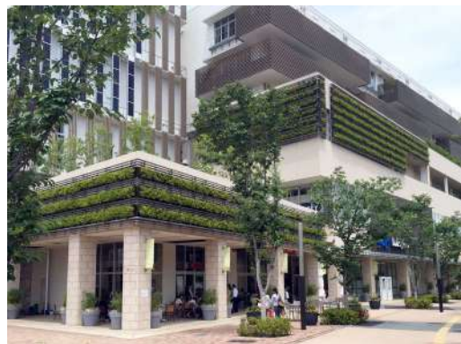
視覚的な緑量を増やすため、高木を沿道に配すとともに、壁面緑化等で補っている事例
