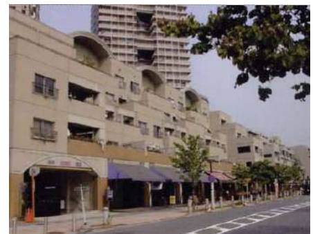
通り側を中層程度とし、高層棟をセットバックしている例
