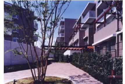
アプローチ広場から住棟を見る(撮影: 齋部功)
