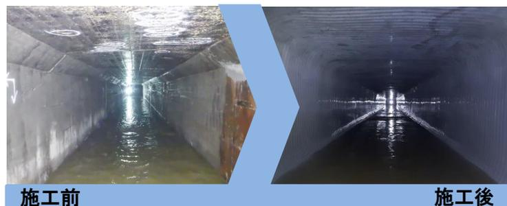
(左写真) 製管工法（SPR工法）による施工状況
