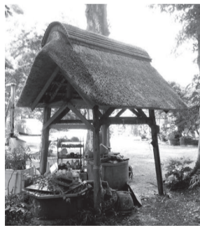
▲明治前期に建てられた井戸上屋
