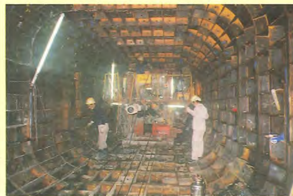
雨水管の直径はこんなに大きい
