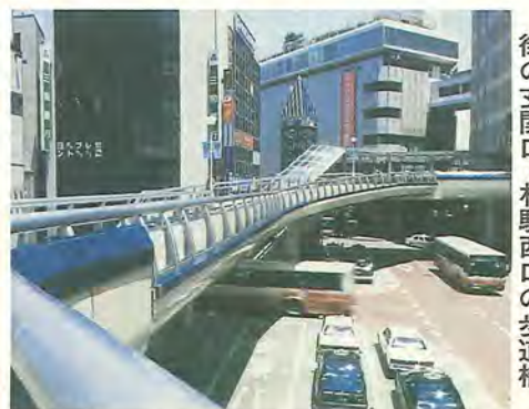
街の玄関口・柏駅西口の歩道橋
