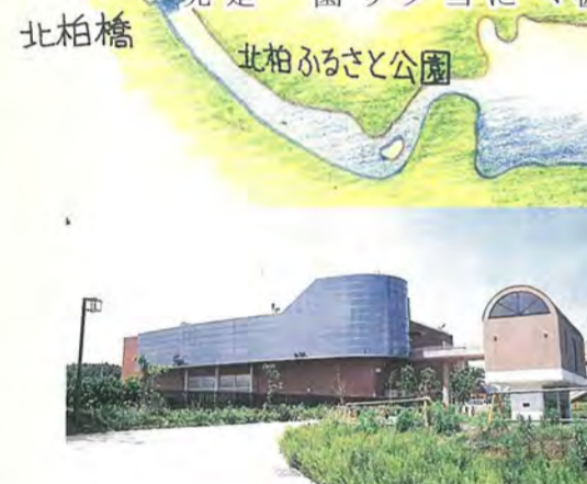
北千葉導水路
