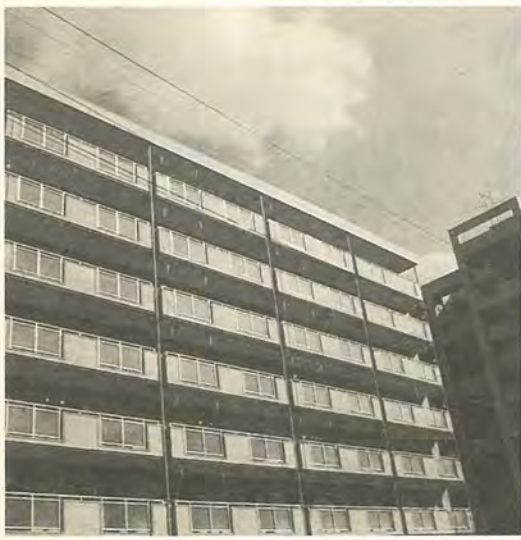
現在、外まわりを工事中(市営北柏団地B棟)
