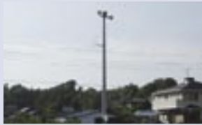
防災行政無線塔
