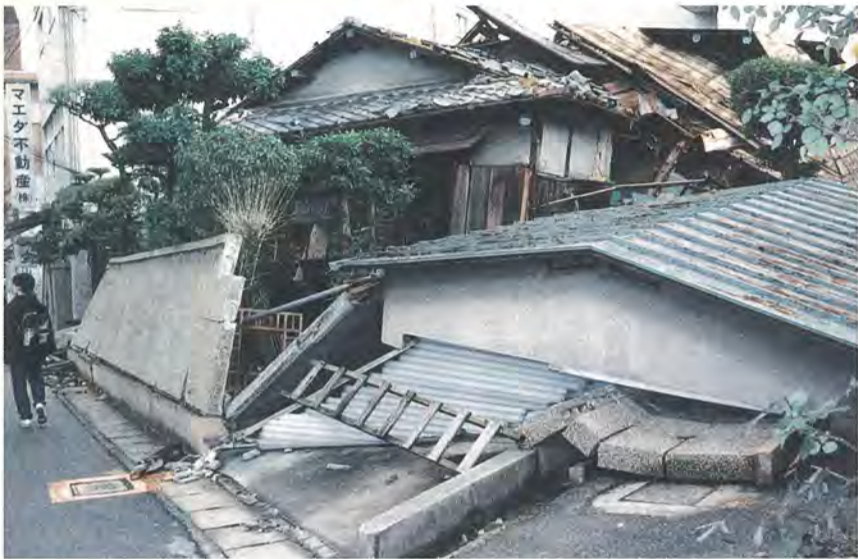
阪神・淡路大震災で倒壊した建物
