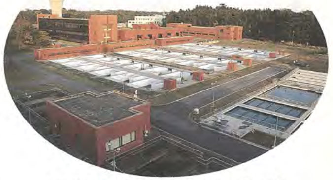
東葛地区に水を供給している北千葉浄水場
