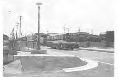
建設省により工事が進められていた、高田105番1先の大堀川に架かる「青葉橋」が開通しました。
