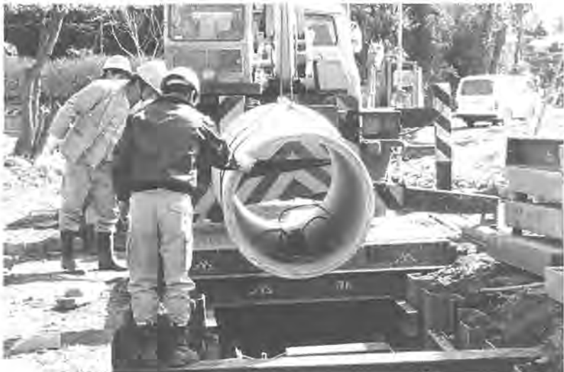
着実に進む公共下水道整備
