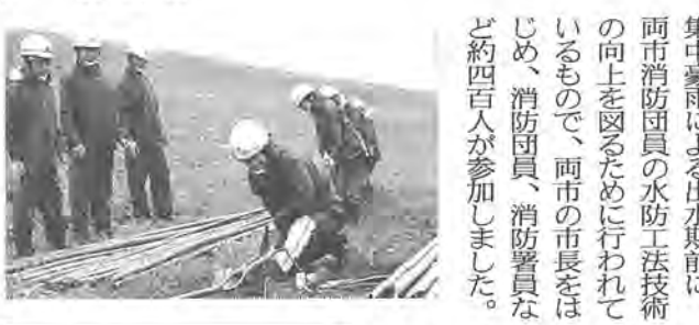
集中豪雨による出水期前に、両市消防団員の水防工法技術の向上を図るために行われていたもので、両市の市長をはじめ、消防団員、消防警員など約四百人が参加しました。
