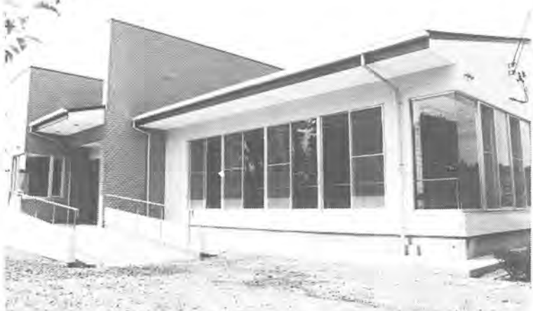
デイ・サービスセンター八幡苑の全景
