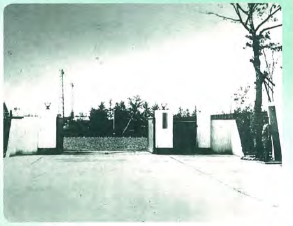
高射砲第二連隊営門(県道我孫子・関宿線の布施入り口付近)。連隊は、昭和13年に当時の富勢村に開隊。18年に廃されるまで駐留。(昭和13～18年ごろ撮影)
