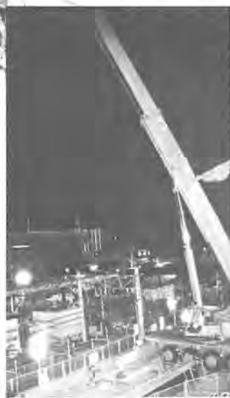
今回は、「北側自由通路」の架設工事。七月二十五日と二十九日の両日、午前一時半から国鉄の送電を止めて行われました。二十五日には長さ一七・五メートル、重さ九・五トンの橋げたを二本、二十九日には長さ二七・五メートル、重さ一三・五トンの橋げた二本が架けられました。
