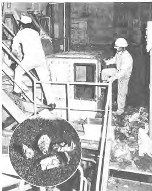
カセット式ガスボンベ（写真左下）が破碎処理機の中で爆発し、大きな被害がでました（昨年5月撮影）
