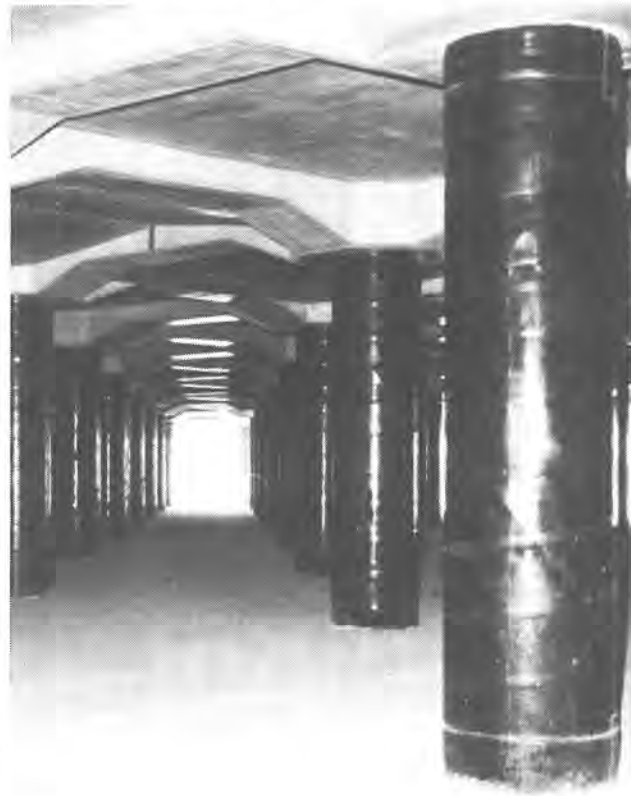
校庭下には鋼管杭(くい)が194本も
