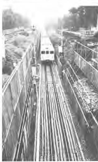
複線化される逆井―増尾間(拡幅中の増尾橋から撮影)
