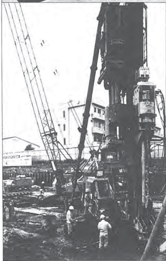
急ピッチで進められている工事＝写真は6月撮影
