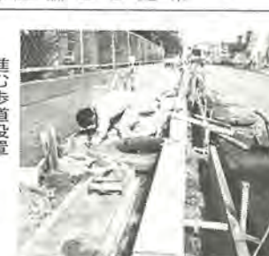
進む歩道設置 (光ヶ丘小学校前)
