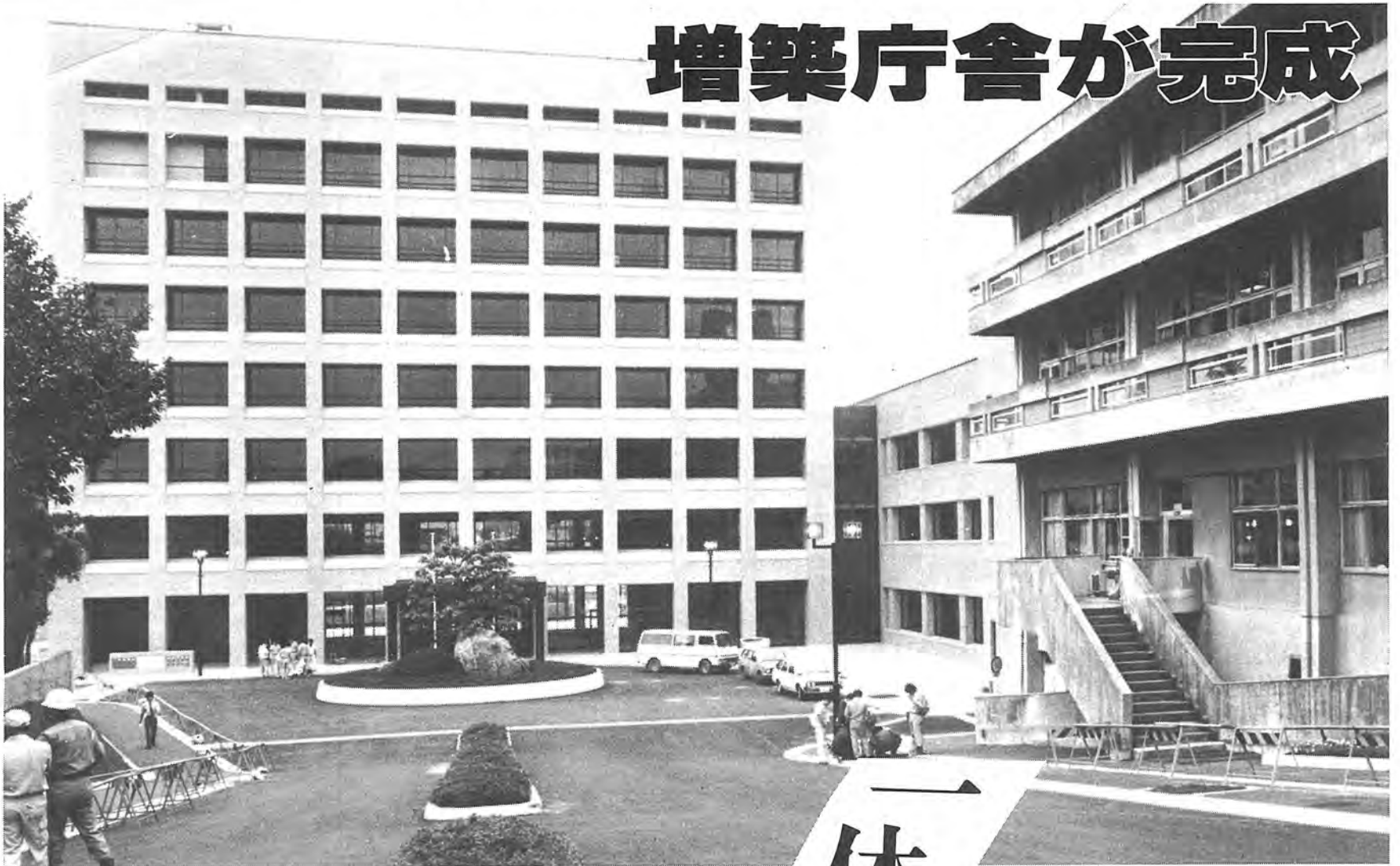
開庁を待つばかりの増築庁舎。1階部分からの高さ約30メートルの高層棟は、市役所の新しい顔となりそうです。ロータリーの中には市の木カシワを植えました。右は現庁舎
