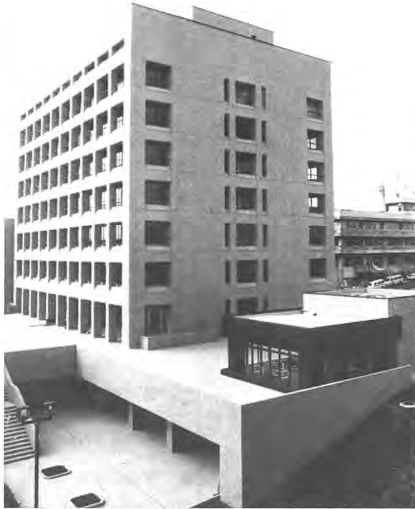
教育福祉会館から見た増築庁舎。手前の建物は喫茶室。その地下には食堂が設置されます。市民のみなさんも大いに利用してください
