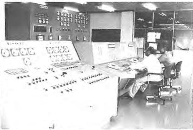
市内6カ所の水源地の様子を監視する中央監視 室。ここで各水源地を遠隔操作しています
