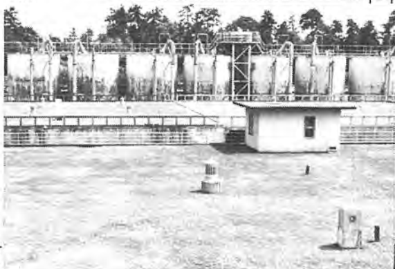
▲後方に見えるのが鉄・マンガンろ過する、除鉄・ 除マンガン装置。手前は、配水量を調整する配水池
